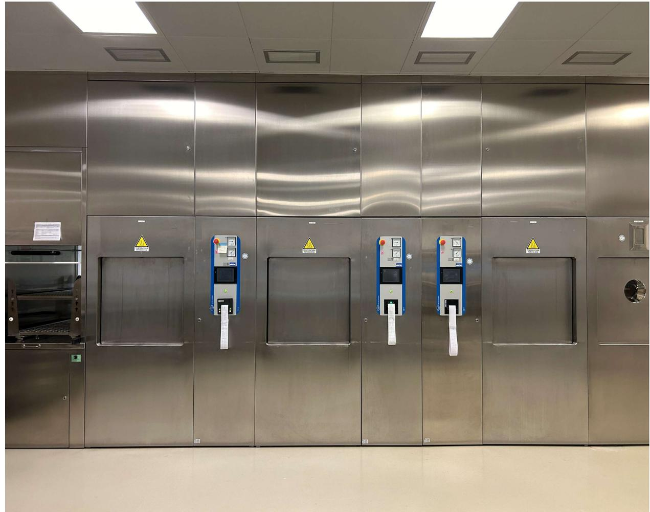
L'autoclave è costituita da una camera di sterilizzazione, avvolta da un'intercapedine e da una pompa aspirante (per rimuovere l'aria presente nella camera). L'autoclave può essere provvista di una o due porte contrapposte con chiusura automatica o manuale. L'apparecchiatura è rivestita da una pannellatura d'acciaio con un accesso frontale o laterale.
